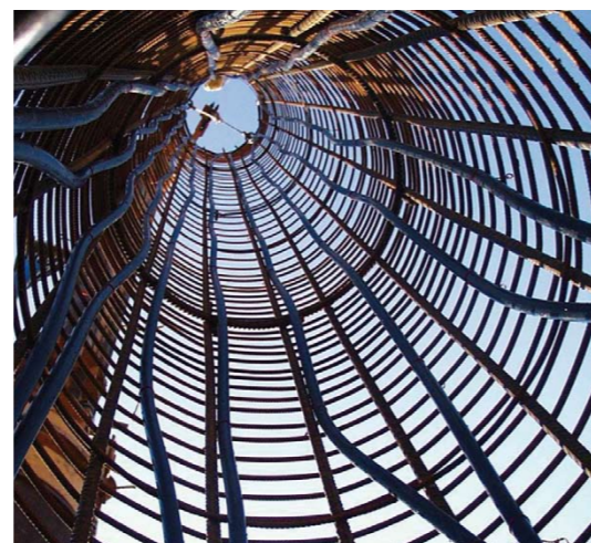
Ausrüstung eines Energiepfahlkorbes
